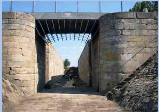
Bei der Sanierung der Schleuse wurde die Betonbrücke mit einer Lamellenkonstruktion versehen, die die Formgebung der ursprünglichen Brücke aufgreift und zitiert. (Foto: Fritz Sitzmann)
